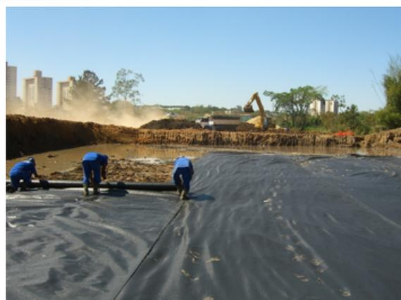
foto 2 – Geotêxtil tecido em reforço sobre solo mole
