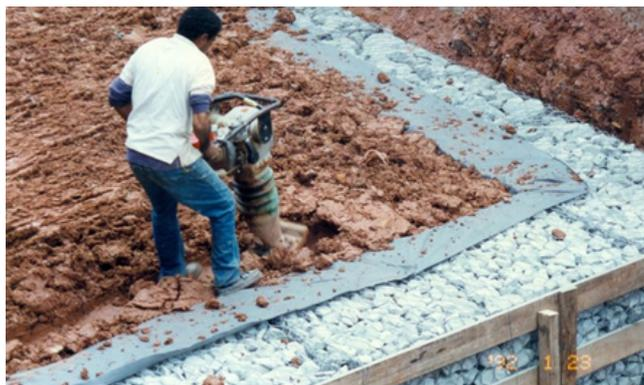
Foto 4 – Geotêxtil não-tecido em filtração
