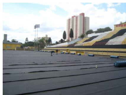
Foto 8 - Geotêxtil não tecido em sistema de drenagem
