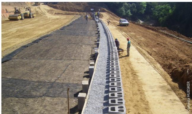
Foto 3 – Geogrelha em muro de contenção
