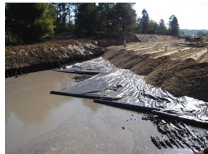
Foto 7 - Geotêxtil tecido de poliéster em aterro sobre solo mole
