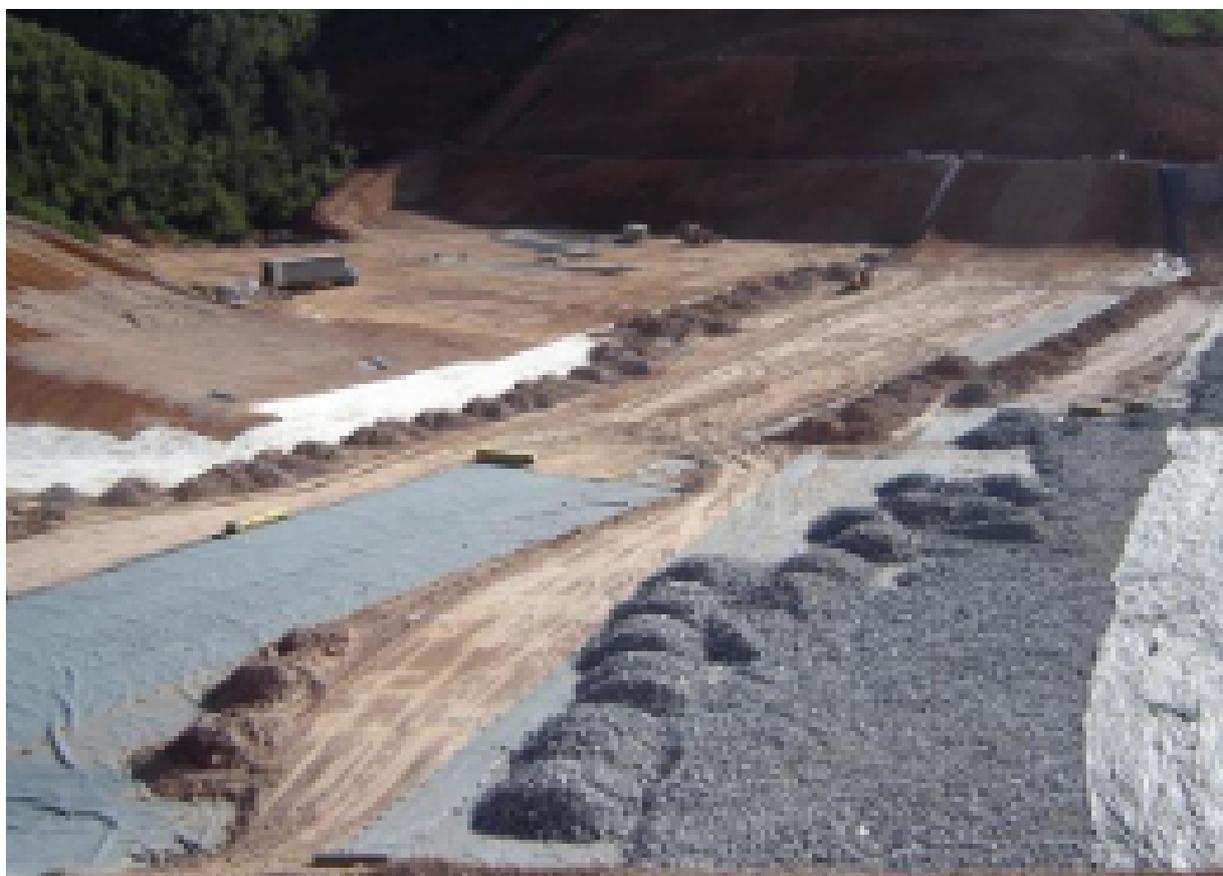
**FIGURA 4 - APLICAÇÃO DE GEOSSINTÉTICOS EM UM PROJETO DE ATERRO SANITÁRIO**
