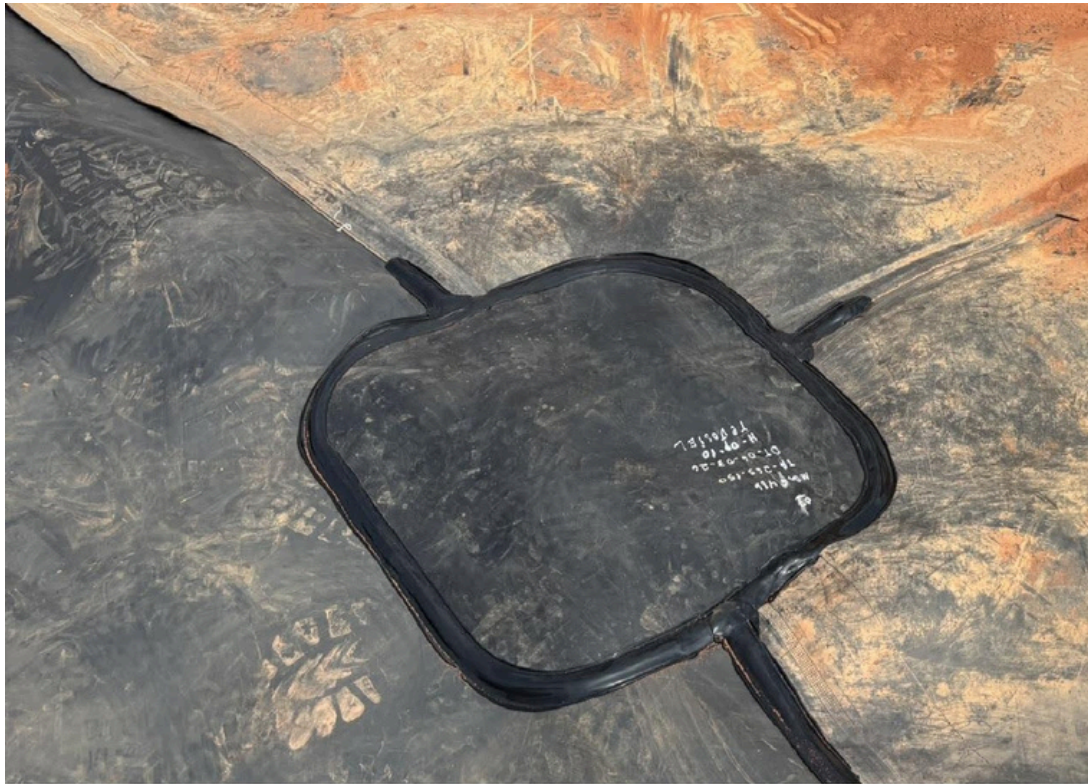
Figura 1 – Exemplo de manchão bem executado.
